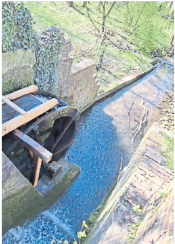
Klipp-klapp macht es wieder an der Berkel, seit das neue Mühlrad eingebaut ist.
